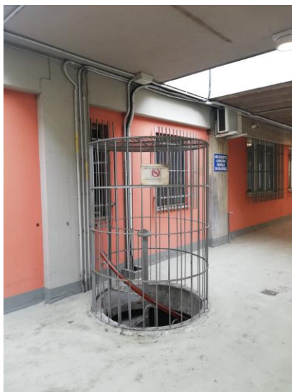
ACCESSO AL LOCALE INTERRATO
